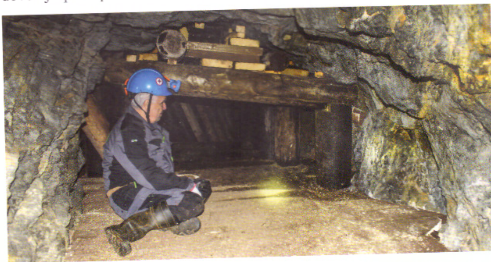
Oprava párové dřevěné výztuže a počvy mihadlové chodby štoly Dlouhý tah
